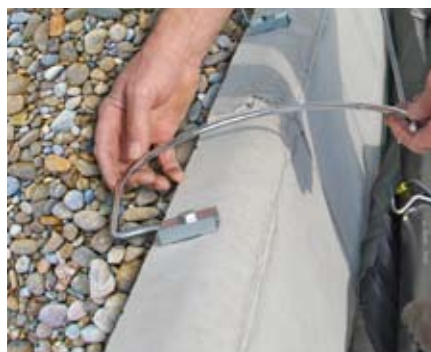
5 Spannfeder flach einsetzen...
