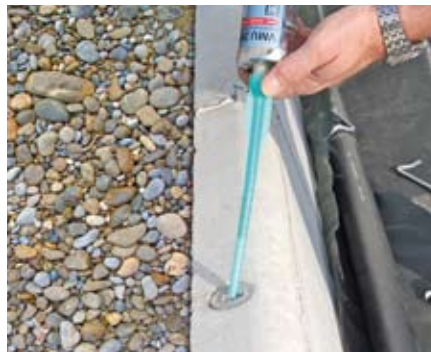
2 Bohrloch mit Multifunktionsmörtel 4 cm auffüllen
