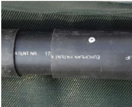
7 Verbindung Kunststoffrohr / Zwischenstück mit Niete fixieren
