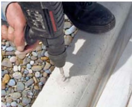
1 Loch bohren; Tiefe ca. 8 cm ( \varnothing 12 mm, alle 1,10 m)
