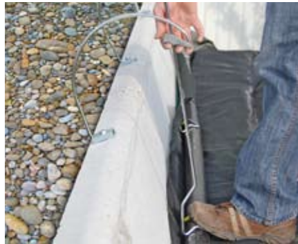
8 Druckstab auf Kunststoffrohr stellen
