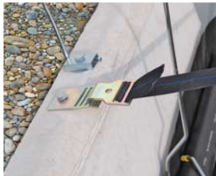
11 Spanngurt als Querverspannung zur Windsicherung
