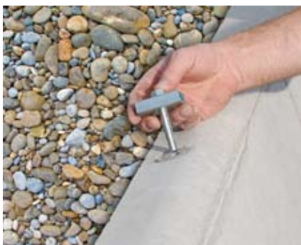
4 Gewindestange (mit Grundplatte und Mutter) in Bohrloch einführen; nach ca. 1 Std. Stopmutter anziehen
