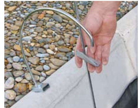
9 Klemmplatte auf Höhe justieren
