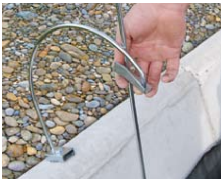
10 Spannfeder mit Klemmplatte vorspannen
