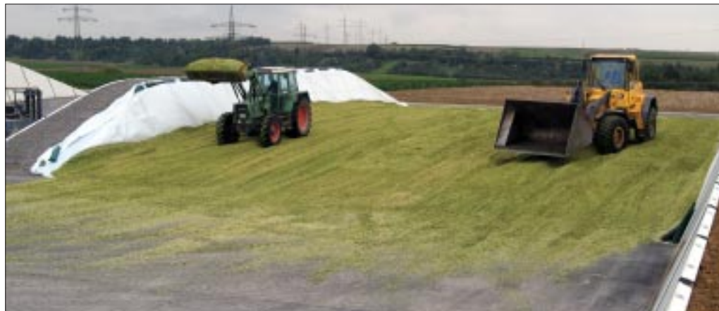
Die schrägen Seitenwände erlauben ein intensives Festfahren des Siliergutes bis ganz an den Rand. Die geringen Verluste machen das im Bau teuerste der untersuchten Silosysteme schon bald rentabel gegenüber Siloplatten und Anlagen mit senkrechten Wänden.
