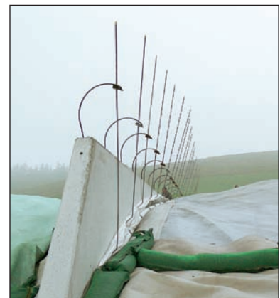
Nur am Silo-Ende werden noch Sandsäcke verwendet.
