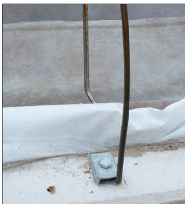
Die verzinkte Grundplatte wird auf der Silowand verschraubt.
